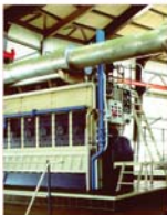
Een kijkje in een gemaal. Als het water in de polder te hoog staat, wordt het door een gemaal eruit gepompt.
